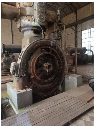
Le compresseur d'air dans la cathédrale des machines
