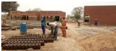
Fabrication des parpaings
